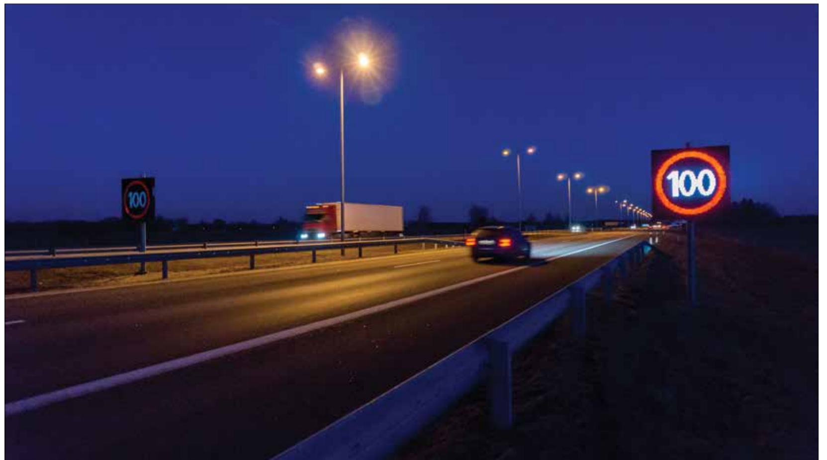
Elektroniniai kintamos informacijos kelio ženklai veikia kaip vaizdo ekranai, kuriuose rodomi greičio ribojimo ir įspėjamieji kelio ženklai, padedantys vairuotojams įvertinti situaciją ir pasirinkti saugų greitį. Magistralė A2 Vilnius–Panevėžys.
