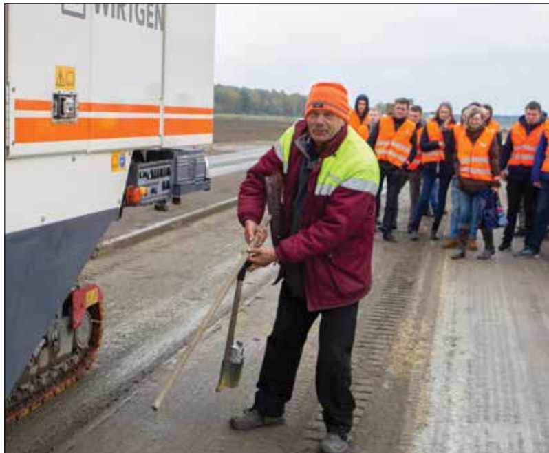
Susidėvėjusios asfalto dangos frezavimo darbai. AB „Panevėžio keliai“ vyresnysis darbų vadovas Domininkas Matiliūnas.
