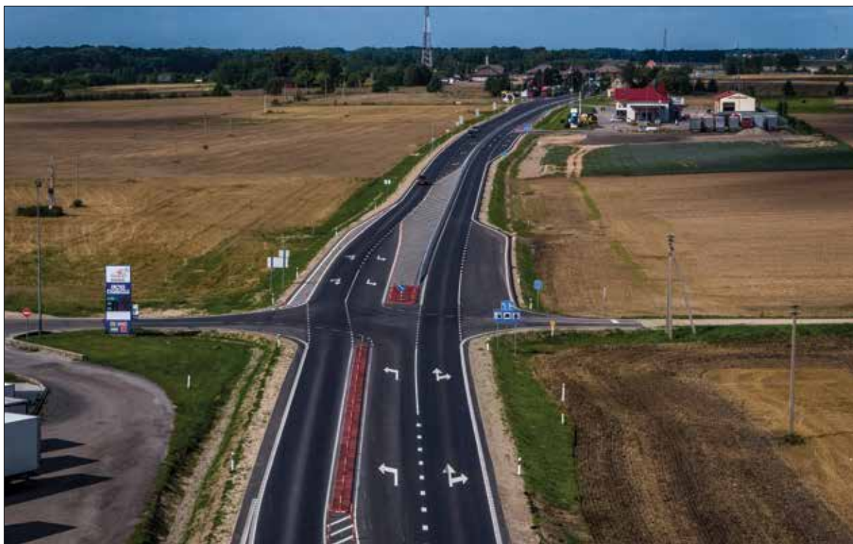
Su Lietuvos ir Latvijos valstybine siena besiribojančiame rekonstruotame 900 metrų ilgio ruože, siekiant jame pritaikyti eismo organizavimo principą 2+1, kelio sankasa išplatinta iki 16 metrų pločio, o vietose, kur įrengtos greitėjimo ir lėtėjimo juostos – iki 18,75 metro.
