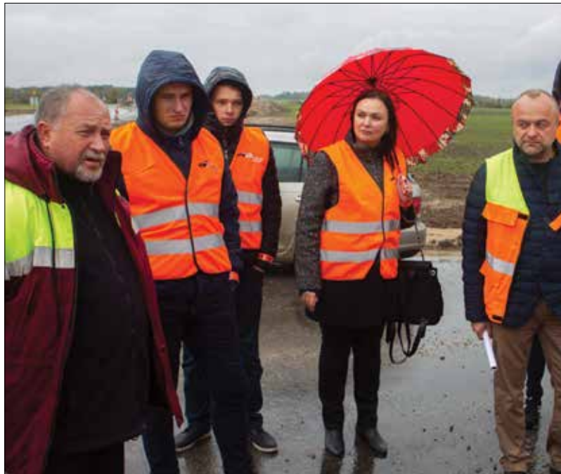
2-jame rekonstruojamo Panevėžio aplinkkelio kilometre, ties posūkiu į „Devold“ gamybos kompleksą, statoma „turbo“ žiedinė sankryža. Objektą pristato AB „Panevėžio keliai“ vyresnysis darbų vadovas Kęstutis Bajarūnas (nuotraukoje – pirmas iš kairės).
