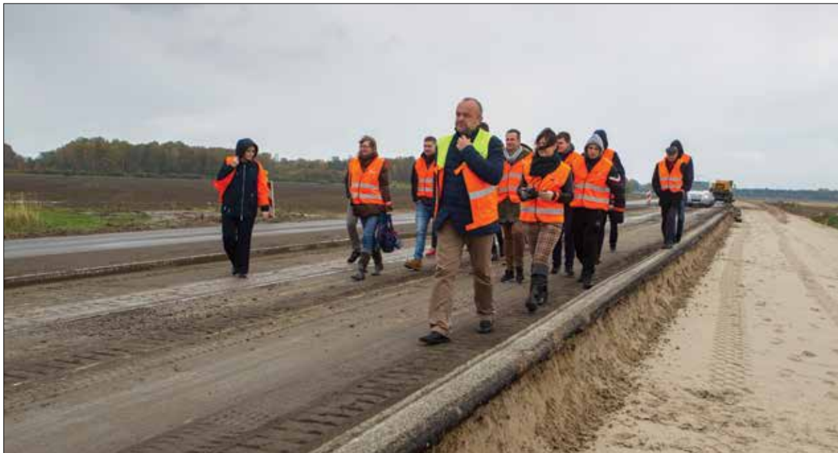
Panevėžio aplinkkelyje, kur atliekami projekto „Valstybinės reikšmės magistralinio kelio A17 Panevėžio aplinkkelio, sutampančio su tarptautinės magistralės „Via Baltica“ trasa, rekonstrukcijos pirmasis etapas“ darbai. Objektą pristatė AB „Panevėžio keliai“ Panevėžio filialo direktoriaus pavaduotojas statybai Saulius Stravinskas.
