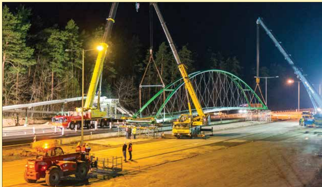
Magistralėje A2 darbai apėmė pėsčiųjų viaduko avaringame ruože ties Žemaitkiemio sankryža statybą, magistralės platinimą įrengiant greitėjimo ir lėtėjimo juostas, jungiamųjų kelių abiejose kelio pusėse bei dviejų žiedinių sankryžų įrengimą.
