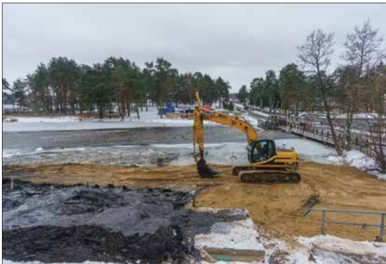
2016 metais objekte buvo šalinami medžiai, kelmai, nuimamas augalinis sluoksnis, įrengiami privažiavimo keliai.
