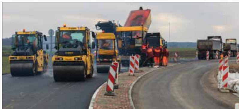
Asfaltbetonio dangos klojimo darbai Ūtos sankryžoje.
