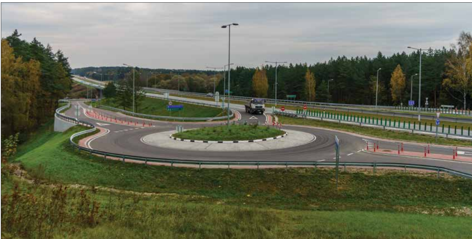
Magistralėje A2 ties Žemaitkiemio sankryža įrengtos greitėjimo ir lėtėjimo juostos, jungiamieji keliai abiejose kelio pusėse ir dvi žiedinės sankryžos.
