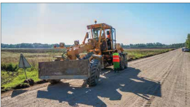
Parengiamieji darbai kelyje link Juostaviečių.
