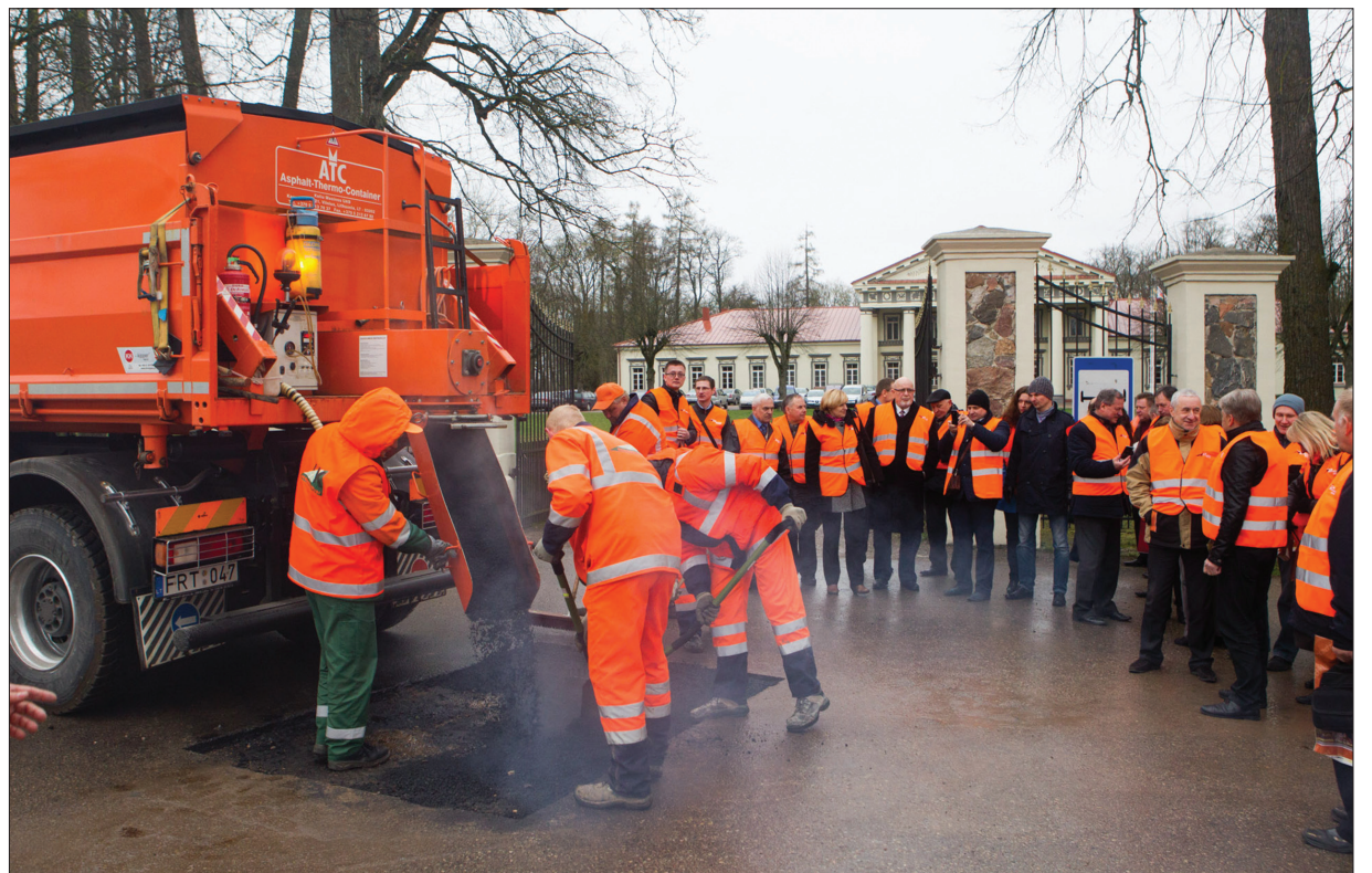
Pasirinkus duobių taisymo kelią, šį darbą taip pat reikia atlikti labai kokybiškai. Pirmiausia, duobei frezos pagalba turi būti suteikiama taisyklinga forma. Kitas etapas – gruntavimas bitumo emulsija. Paklojus asfaltbetonio mišinį, jį reikia tinkamai sutankinti.
