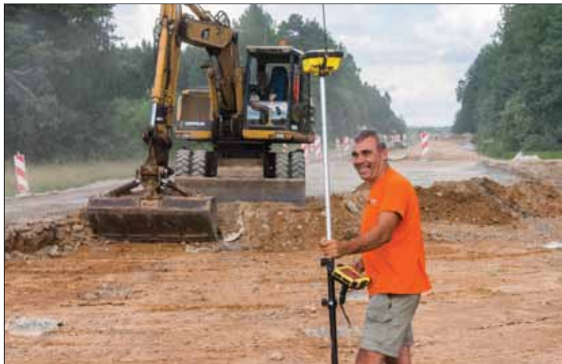
Ekskavatoriaus mašinistas Algimantas Paišius, dirbantis su 3D aparatu, sumontuota ant ekskavatoriaus.
