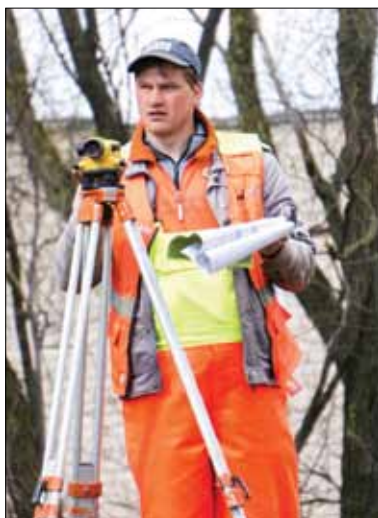
Mantas Jokubauskas, „Rail Baltica“ statybos darbai Marijampolėje.
