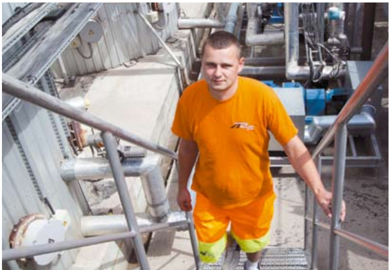
Bitumo gamybos įrengimus prižiūri bitumo ruošimo operatorius Raimondas Čepelė.
