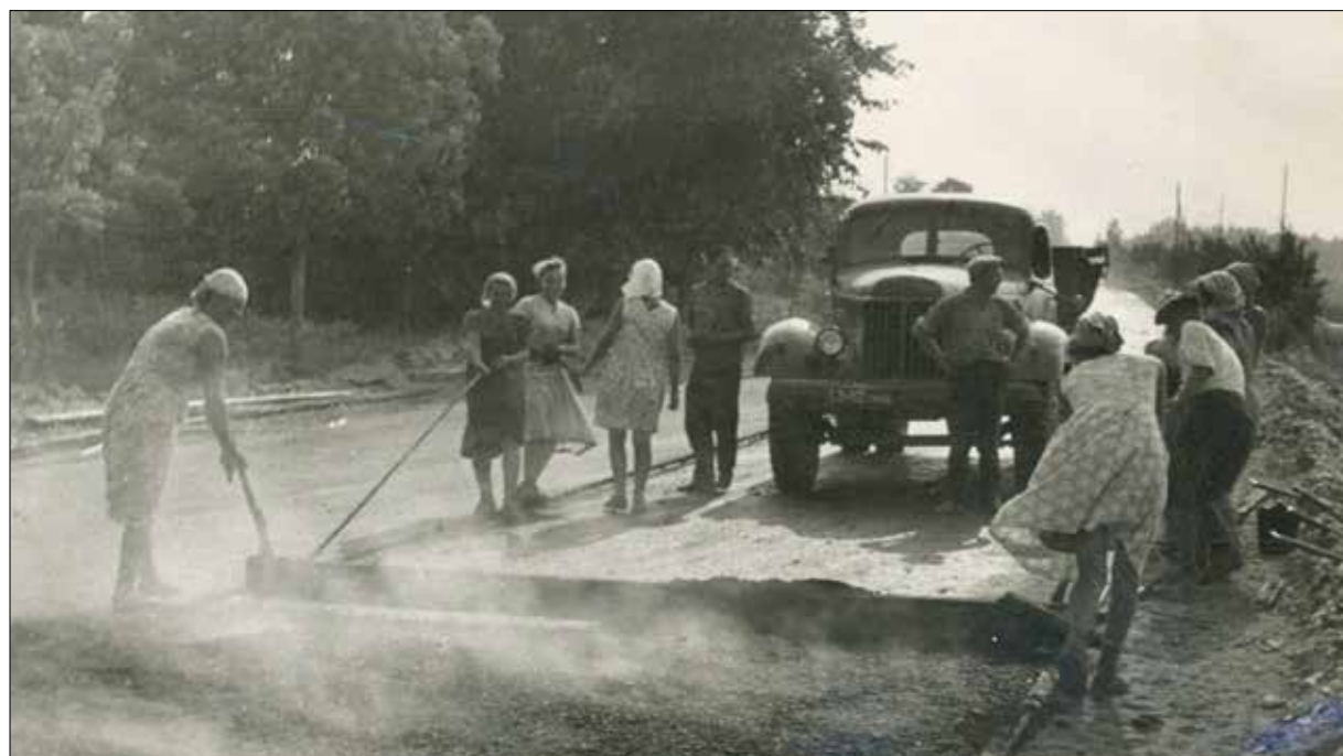
Vykdomi asfaltavimo darbai Panevėžio rajone. Dirba Subačiaus moterų asfaltuotojų brigada. 1965 metai. Nuotrauka iš KSV-5 mechaniko ir racionalizatoriaus Romo Sabo archyvo.
