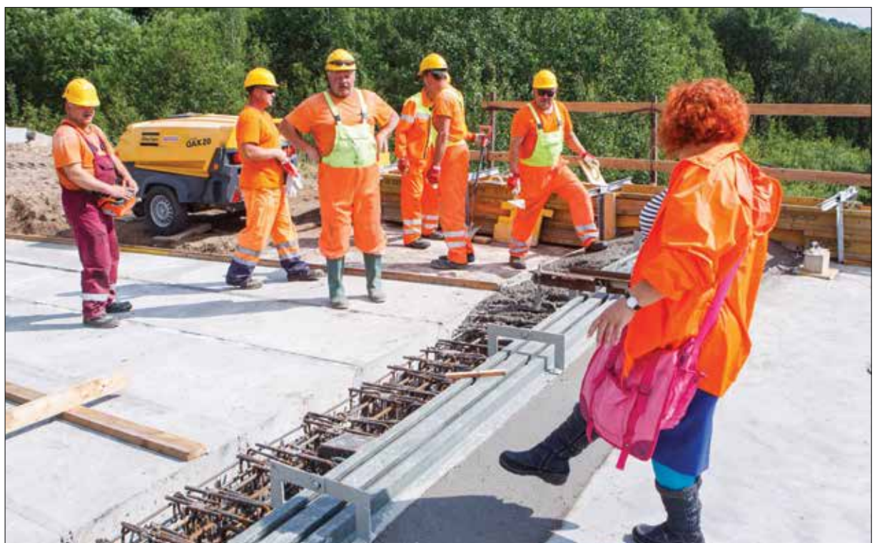
Kai kam labai pasisekė, kad neįtapnojo į neseniai išlietą betoną, nes ant tilto dirbančių vyrų žvilgsniai labai iškalbingi.
