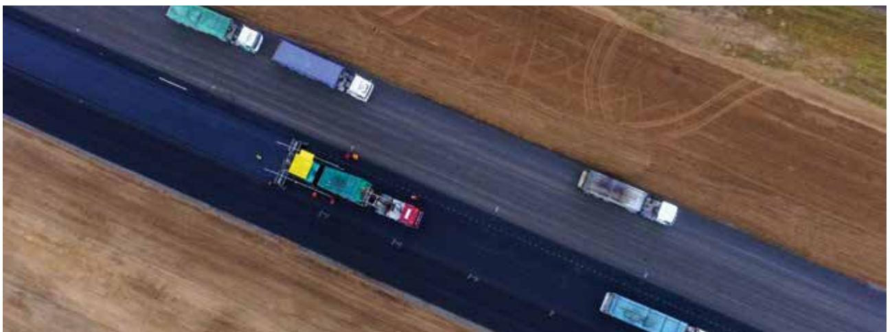
VG TU Antano Gustaičio aviacijos instituto Kyviškių skrydžių praktikų bazės kilimo ir tūpimo takas. Asfaltbetonio dangos klojimo darbai.
