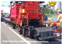
Dangos frezavimas, mišinio regeneravimas ir paklojimas
