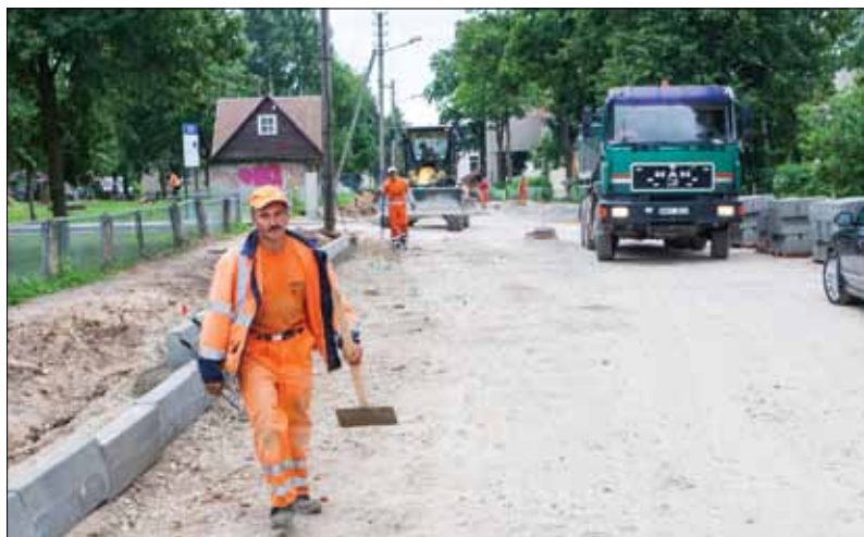
Bažnyčios gatvės rekonstrukcijos darbai Ukmergės mieste. Nuotraukoje – kelio darbininkas Ričardas Krikštaponis.
