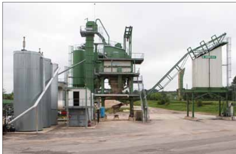
Jogvilų asfaltbetonio bazė.
