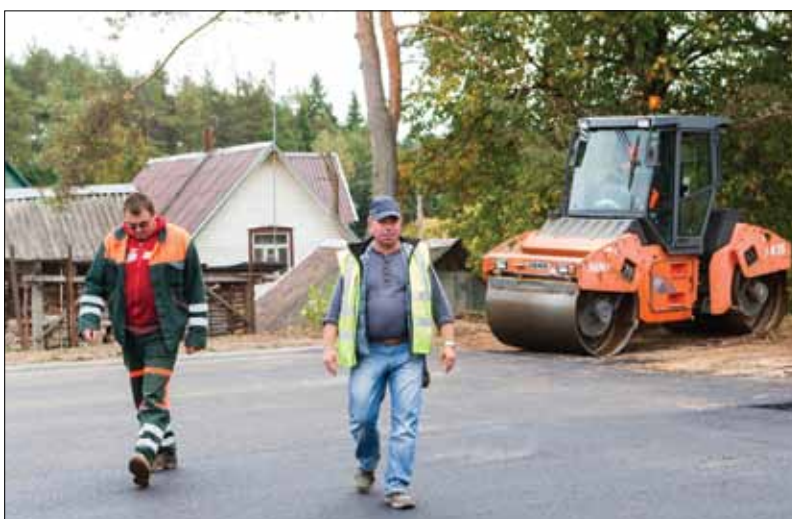
Asfaltavimo darbai „Viešosios infrastruktūros sutvarkymas Utenos rajono Saldutiškio miestelyje“. Nuotraukoje iš kairės: kelių statybos mašinų mašinistas L. Veteikis, statybos vadovas V. Speteliūnas.
