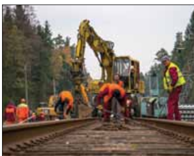
Demontuojami senieji bėgiai.
