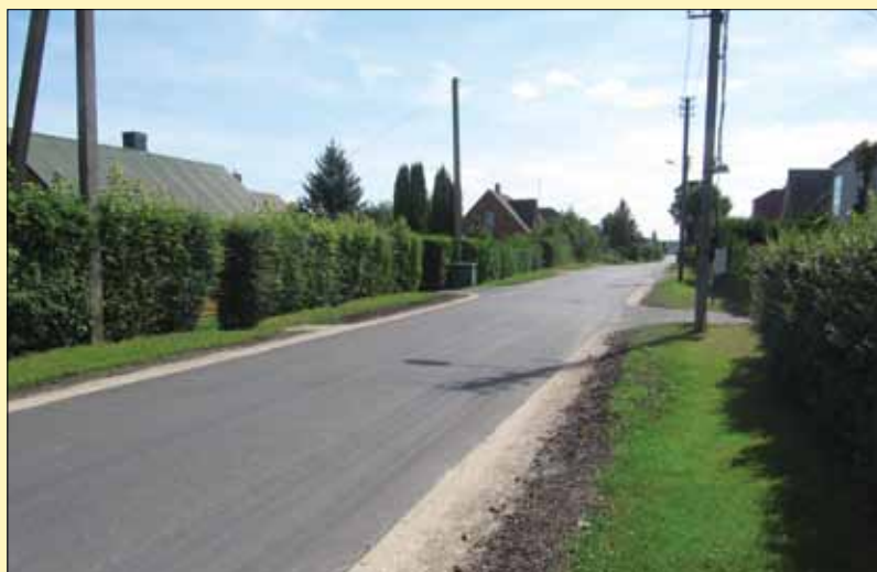
Biržų mieste šį darbų sezoną bendrovė vykdo eilę miesto susisiekimo infrastruktūros projektų. Nuotraukoje – atlikti V. Kudirkos gatvės rekonstravimo darbai.
