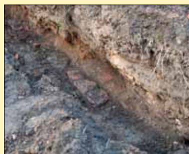
Rengiant elektros linijos tranšėją, po velėna aptiktas dirvožemio sluoksnis su XIX-XX a. radiniais, išlikusiomis rausvomis plytomis.
