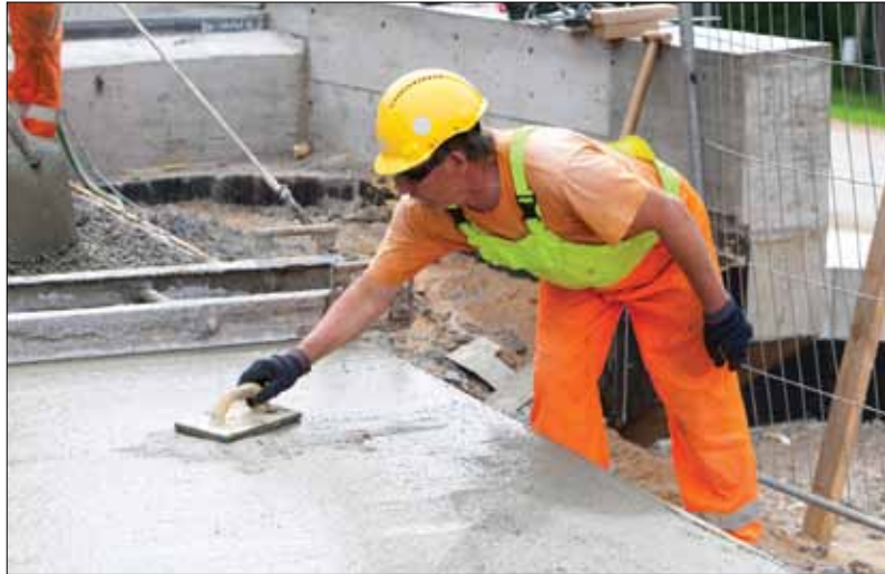
Betono išlyginamojo sluoksnio įrengimas. Nuotraukoje – brigadininkas Antanas Vilčinskas.
