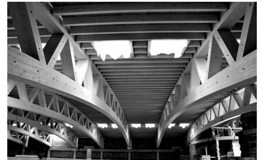
UAB „Jūrės medis“ medinės klijuto medžio konstrukcijos sporto komplekse Lenkijoje.
