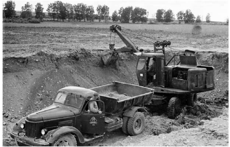
Technika naudojama keliams tiesti, 1960 metai. Ekskavatoriumi Prūselių karjere dirba Grabauskas, žvyras kraunamas į savivartį ZIL.
