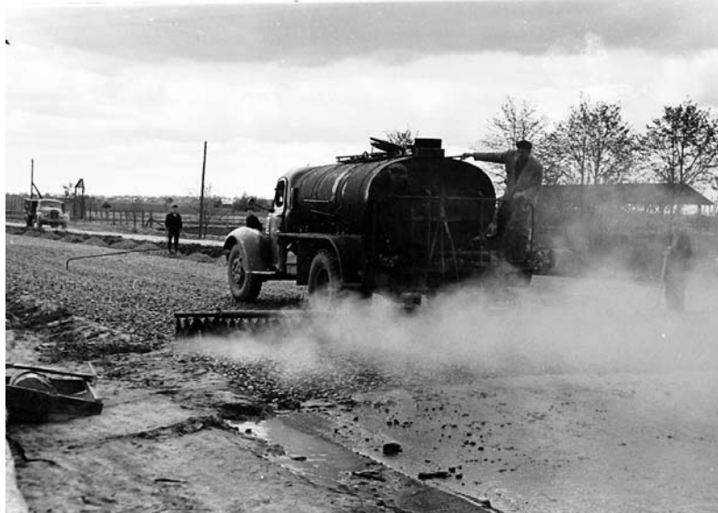
Pirmojo juodos dangos kelio ruožo nuo Rokiškio geležinkelio stoties iki Respublikos gatvės įrengimo darbai. (vieta prie buvusio šieno priėmimo punkto) 1960-ųjų pavasarį. Autogudronatoriumi bazėje išpilamas bitumas ant paruoštos dangos.
