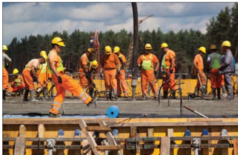
Jau ketvirtąjį sezoną bendrovėje dirba Dovydas Motieka (priekyje). Nuotraukoje - estakados betonavimo darbai.
