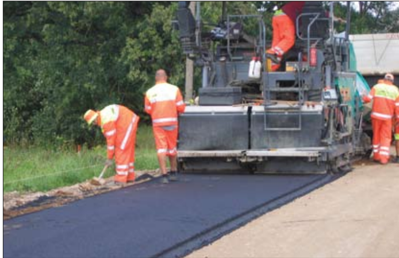
Darbai kelio Subačius-Čečeliai ruože, per Čečelių gyvenvietę.
