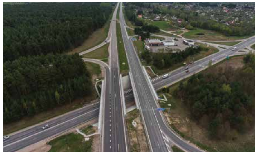
Rekonstruoti Dukstynos viadukai, esantys magistralės 74,68 km, kairėje ir dešinėje kelio pusėje.
