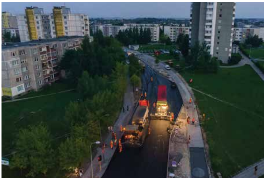
Panevėžio miesto Projektuotojų gatvės dalies rekonstrukcijos darbai.
