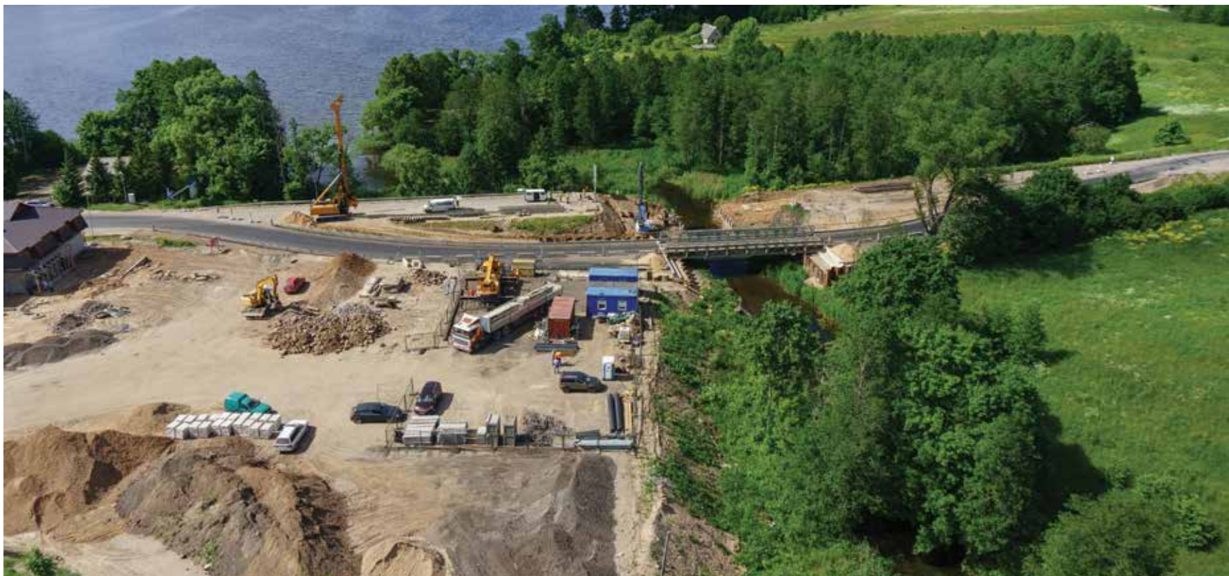
Laucesės tilto rekonstrukcijos darbai. Bendrasis tilto ilgis – 25 metrai, važiuojamosios dalies plotis – 9 metrai.
