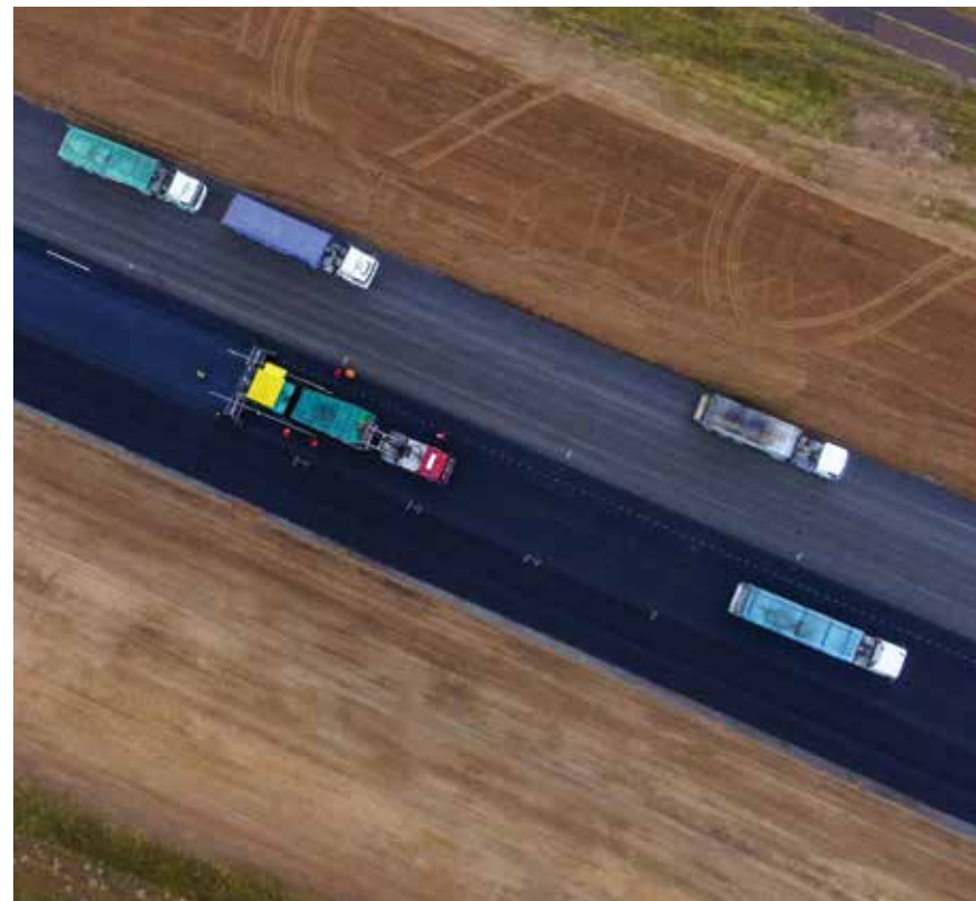
VGTU Antano Gustaičio aviacijos instituto Kyviškių skrydžių praktikų bazės kilimo ir tūpimo tako asfaltbetonio dangos klojimo darbai.
