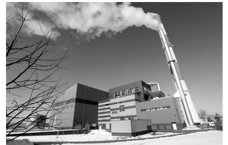
Pastatius Šiaulių termofikacinę elektrinę, šilumos kaina sumažėjo 16 proc.
