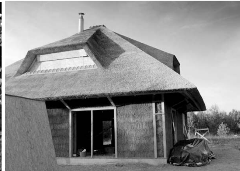
Kardokų kaime tarp Kazlų Rūdos miškų kuriasi ekologinė gyvenvietė. Matome iš šiaudų statomą namą.
